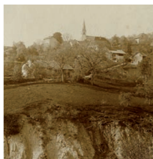
Lucinges vers 1909, vue depuis le ruisseau du Moulin dont les berges sont soumises à des glissements de terrain
