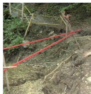
Glissement de berge sur le ruisseau du Moulin, au niveau de la cascade (2008)
