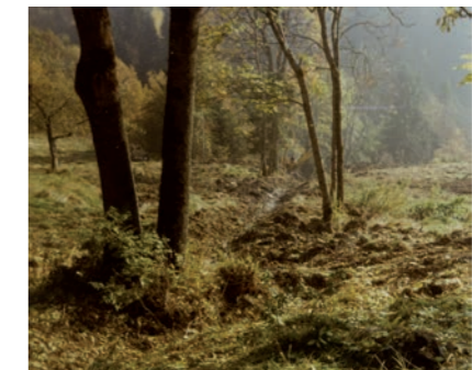
Travaux de drainage et canalisation du Nant d'Aire en 1978
