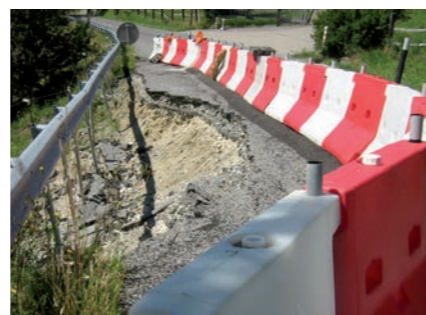
Glissement de talus sous la RD 183 menant à Bellevue (2008)
